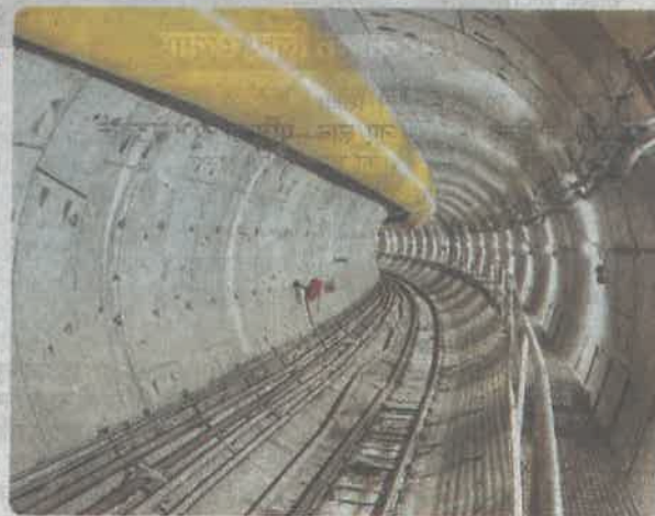
चौक बाजार मेट्रो स्टेशन पर डाऊन लाइन टनल का ब्रेक थू कार्य पूरा
