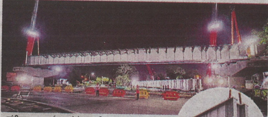
गांधीनगर च-0 सर्कल पर मेट्रो लाइन पिलर पर बड़ा गर्डर लगाते जीएमआरसी कर्मचारी।
