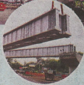
गांधीनगर च-0 सर्कल पर मेट्रो लाइन पिलर पर बड़ा गर्डर लगाते जीएमआरसी कर्मचारी।
